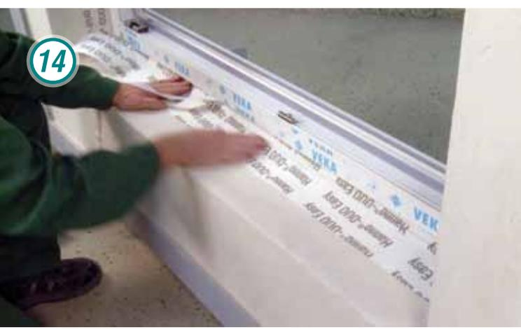
Im unteren Bereich lösen sie zunächst beim Andrückvorgang den schmalen Abdeckstreifen und befestigen das Folienband am Fenstersteg.
