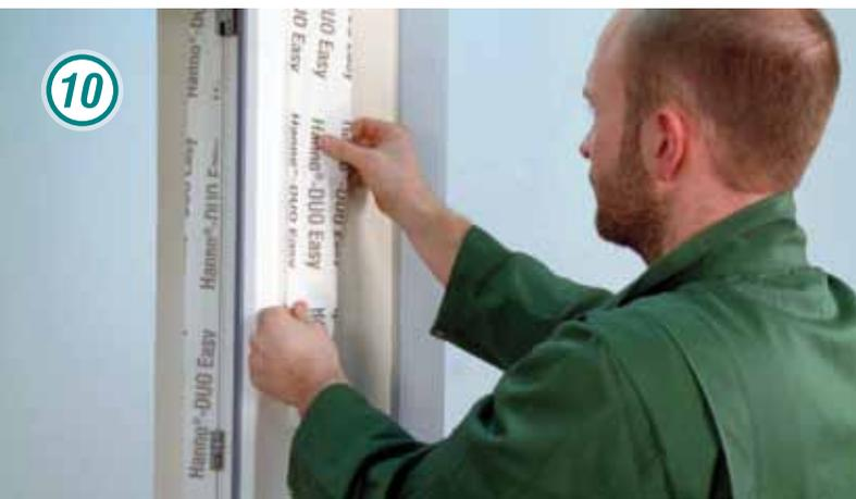
Durch die Feuchtevaribilität der Folien der Hanno®-Folienband DUO Easy 240 Serie können sie mit dieser Folie den inneren- als auch den äußeren Anschluss abdichten. Die vollflächige Selbstklebung erlaubt einfache und schnelle Montage.
