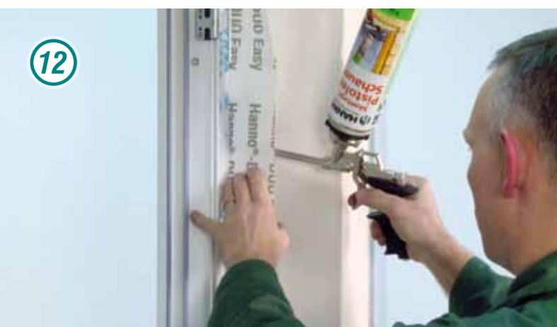
Kleben sie nun Hanno®-Folienband DUO Easy 240 an den Baukörper an. Ziehen sie dazu den Abdeckstreifen erst beim Andrückvorgang ab.
