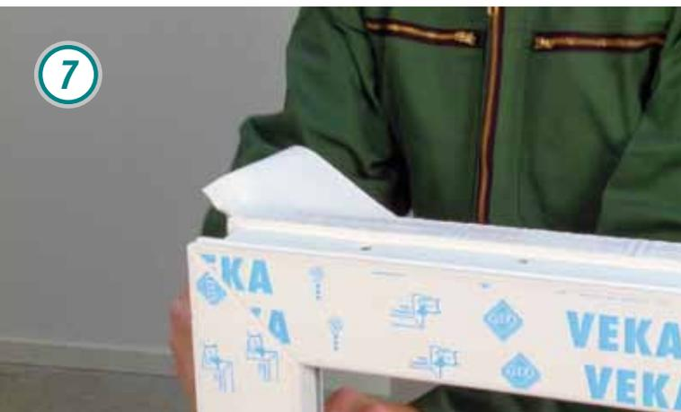
Führen sie das Folienband in den Ecken in einer der Fuge entsprechenden Schlaufe fort.
