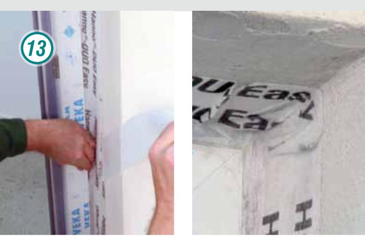
Kleben sie nun Hanno®-Folienband DUO Easy 240 an den Baukörper an. Ziehen sie dazu den Abdeckstreifen erst beim Andrückvorgang ab.
